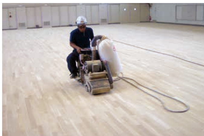
■フローリング改修
